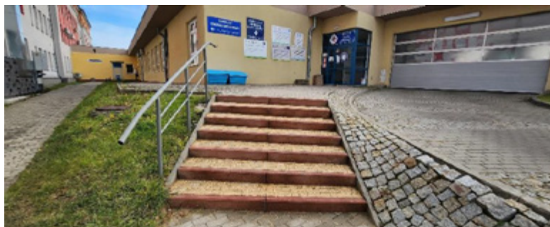
Zdjęcie nr 1: Pochylnia i schody terenowe.
