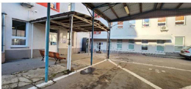
Zdjęcie nr 7: Wejście do Izby Przyjęć.
