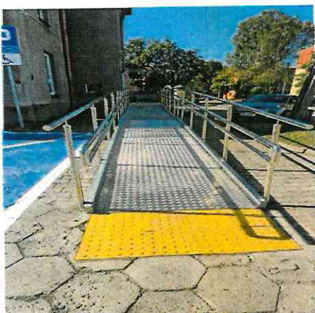
Zdjęcie nr 1: Wykonanie podjazdu zewnętrznego wraz z wejściem do budynku
