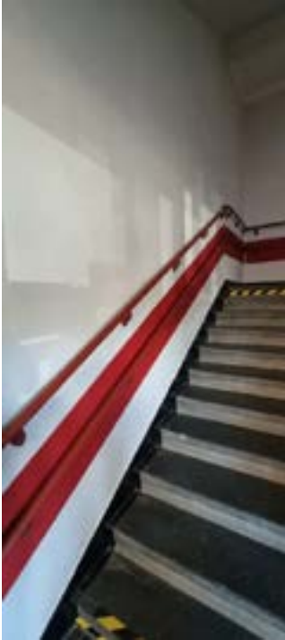
Zdjęcie nr 8: Poręcze na dwóch wysokościach
