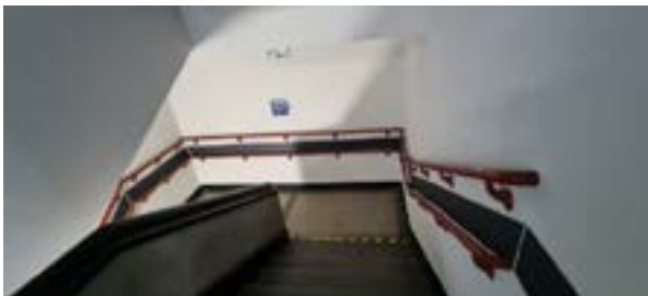
Zdjęcie nr 7: Poręcze na dwóch wysokościach
