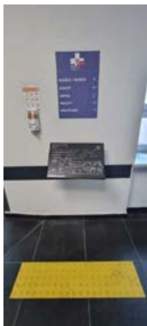
Zdjęcie nr 12: Oznakowanie kierunkowe, oznakowanie systemu identyfikacji szpitala - plany tyflograficzne, pola uwagi
