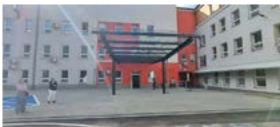
Zdjęcie nr 2: Dojście i parking - zadaszenie nad wejściem
